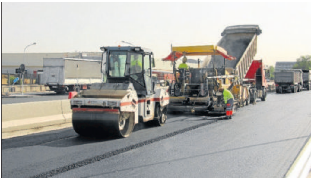
Tramo asfaltado con el material diseñado por Aimplas. EMV
